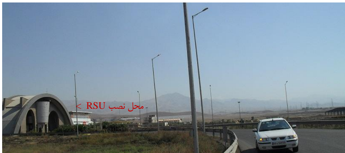
شکل ۱ - موقعیت مکانی نصب RSU در ورودی شهرک صنعتی کاسپین در آزادراه کرج - قزوین
