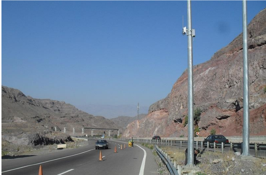
شکل ۲ - نحوه استقرار و موقعیت نصب RSU در محدوده ورودی تونل شیرین سو
