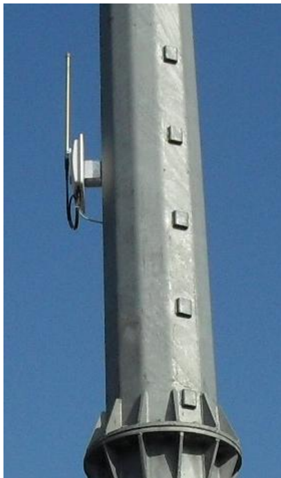
تصاویر ۳ و ۴ - نحوه استقرار و موقعیت نصب RSU در محل خروجی به سمت سنگر و لاهیجان در آزادراه قزوین - رشت
