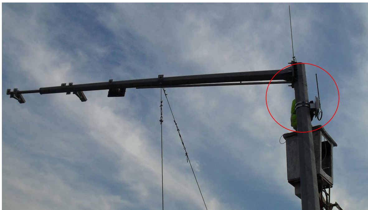
تصویر ۳ - نحوه استقرار و موقعیت نصب RSU بر روی سازه فلزی دوربین‌های کنترل سرعت
